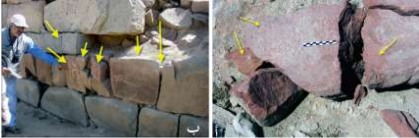
شكل رقم (٥): أ. ضعف وتفتت الكتل الحجرية المتساقطة، ب. انهيار جزئي في أجزاء مختلفة من الجدران
