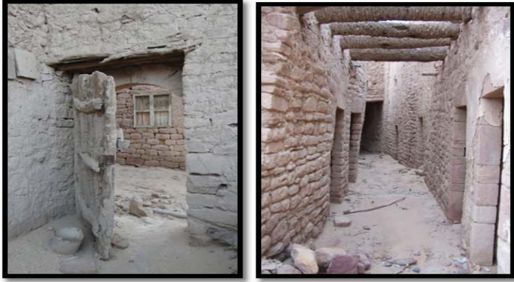
لوحة (٨) استغلال اشجار النخيل فى صناعة الابواب والتسقيف والسقائف
