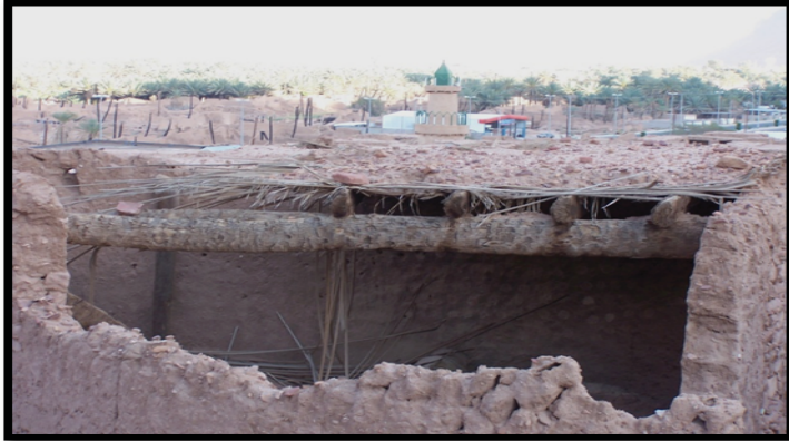
لوحة (٩) استخدام اشجار الطلح والأثل والسمر فى عمليات التسقيف
